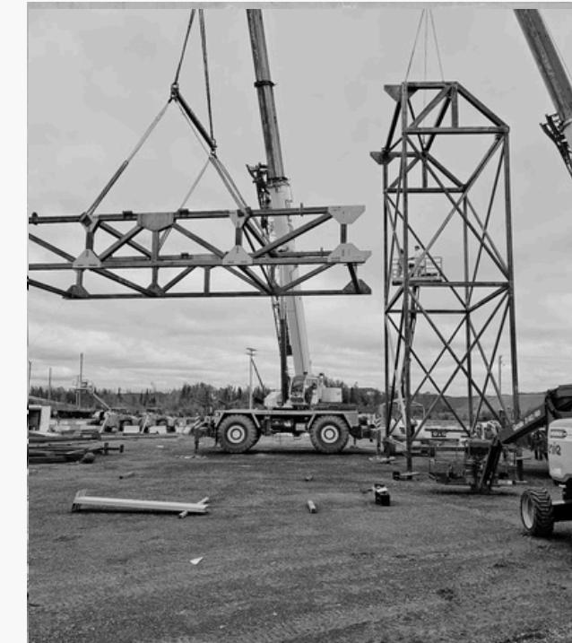
Fabrication et installation d'une structure temporaire sur mesure dans le cadre d'un arrêt annuel de maintenance pour un site minier de la région de Malartic.
